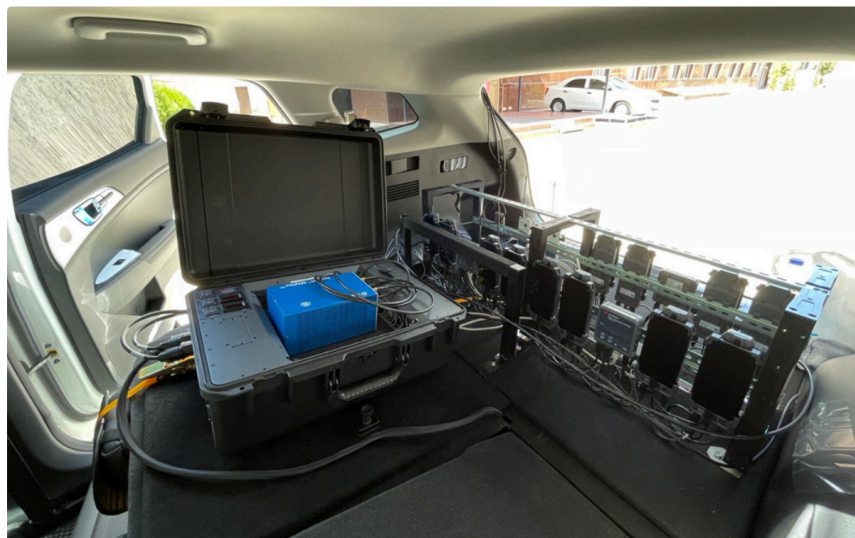
Рисунок 8. Измерительный комплекс, установленный в автомобиле
